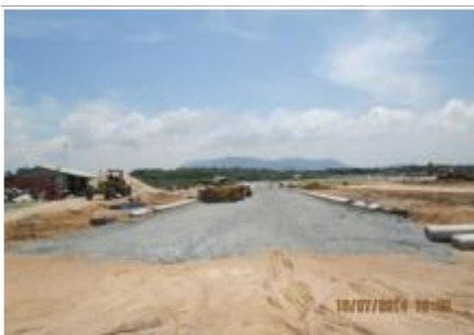
Hoạt động xây dựng khu tái định cư
